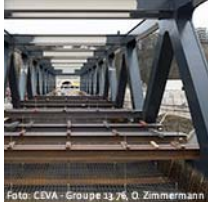
Foto: CEVA - Groupe 3174 O. Zimmermann Neue Brücke in Carouge (GE)
